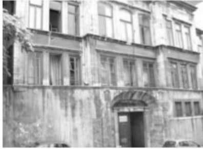
Şekil 8. Subhi Paşa Konağı ön cephe (G. Çelik, 2007).
