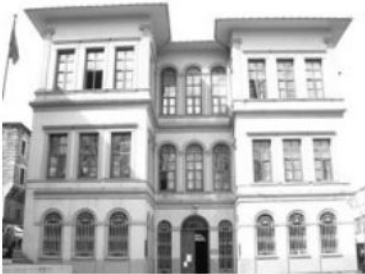
Şekil 12. Mütercim Rüştü Paşa Konağı (G. Çelik, 2007).
