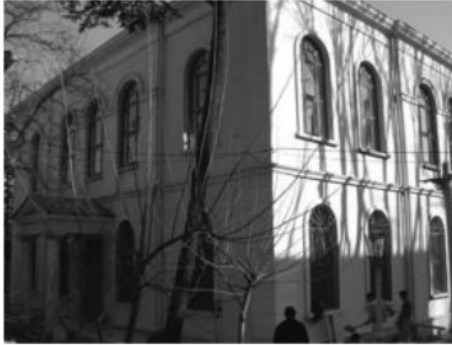
Şekil 2. Hazine-i Evrak Binası, genel görünüm (G. Çelik, 2007).
