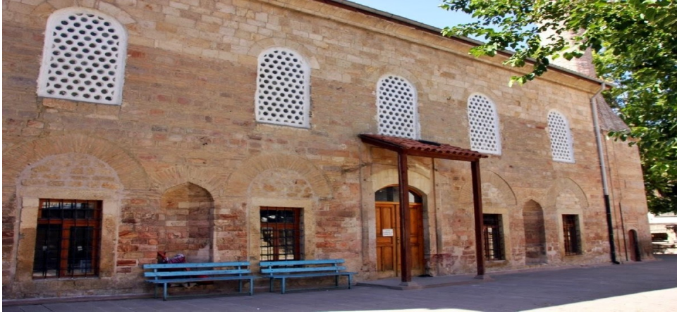
Şekil 5.2. Beypazarı Rüstem Paşa Hamamı (Türk Hamam Müzesi)
